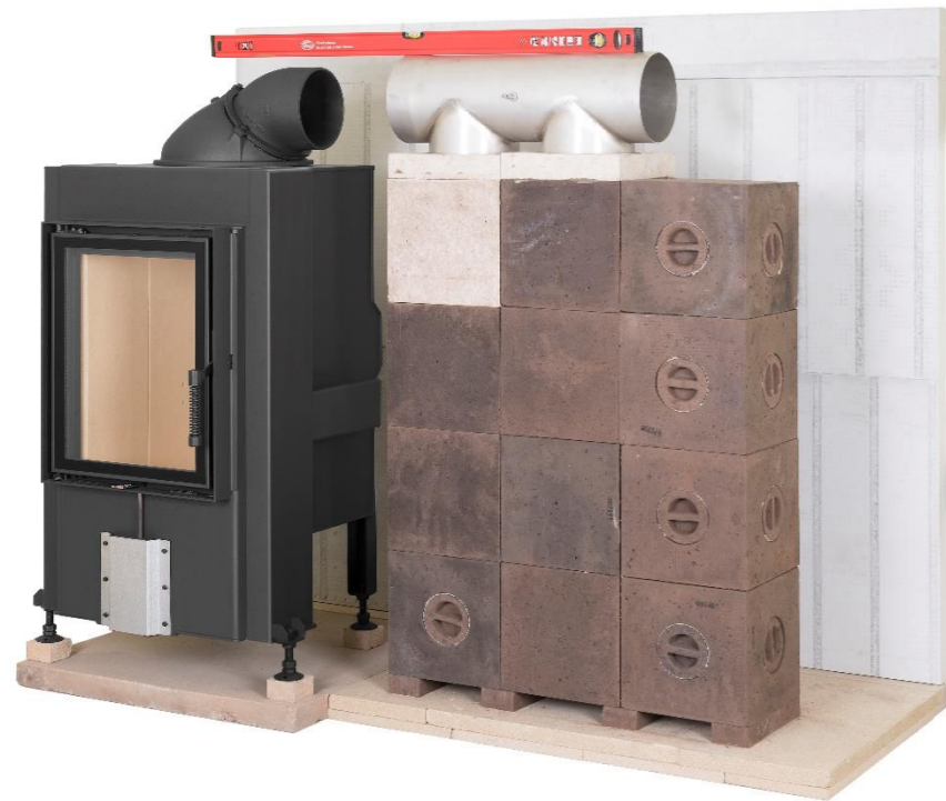
29) Nasazení klapky a proměření rovinnosti s volně nasazenou kopulí.
