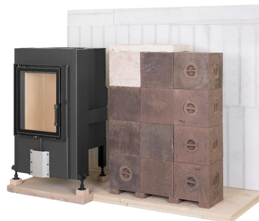
28) Nalepení přechodového kusu č.2
